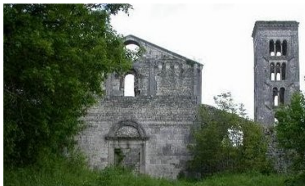
Figura 1 - Pozzaglia Sabina, Santa Maria del Piano, oggi
