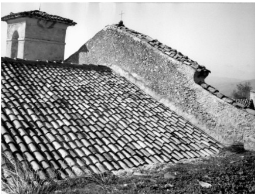
Figura 10 - tetto: particolare del timpano
