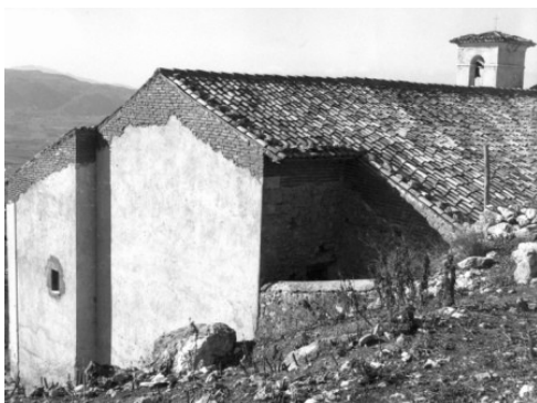
Figura 11 - tetto: parte posteriore
