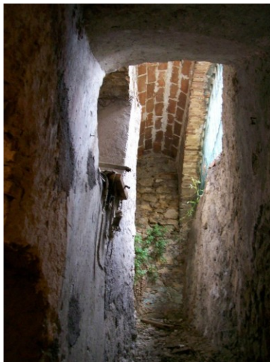
Figura 2 - Finestra della cisterna
