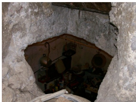
Figura 4 - apertura cisterna: vista alto
