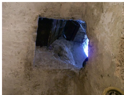
Figura 5 - apertura cisterna: vista basso
