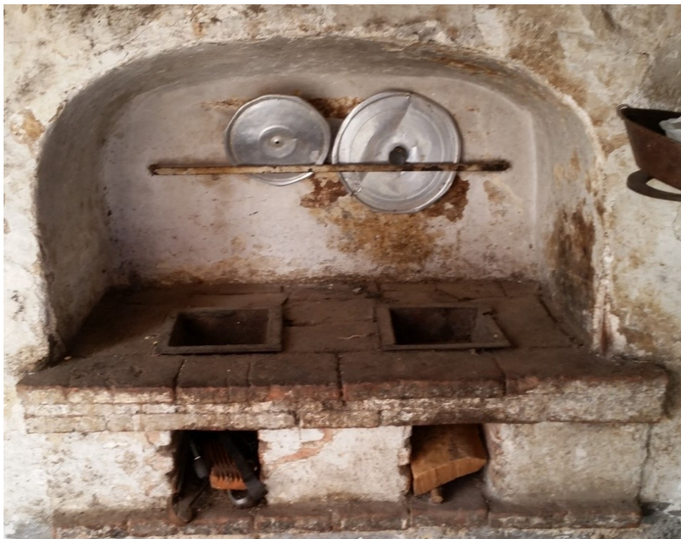
Figura 29 - Fornelli in muratura, angolo cottura
