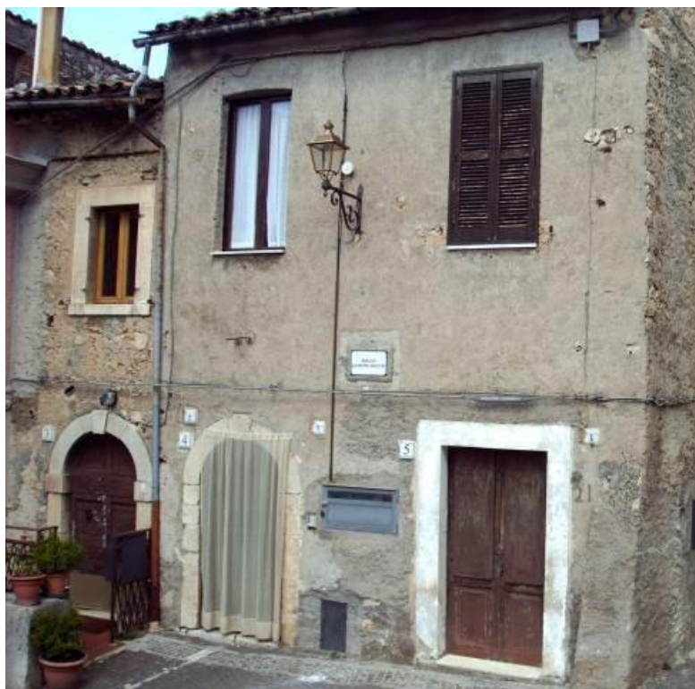
Figura 3 - Fabbricati in piazza Giuseppe Mazzini
