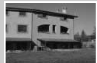
ROCCA DI BOTTE: Soggiorno con camino angolo cottura camera bagno portico giardino attrezzato. Arredato ottimo stato Euro 75.000,00
