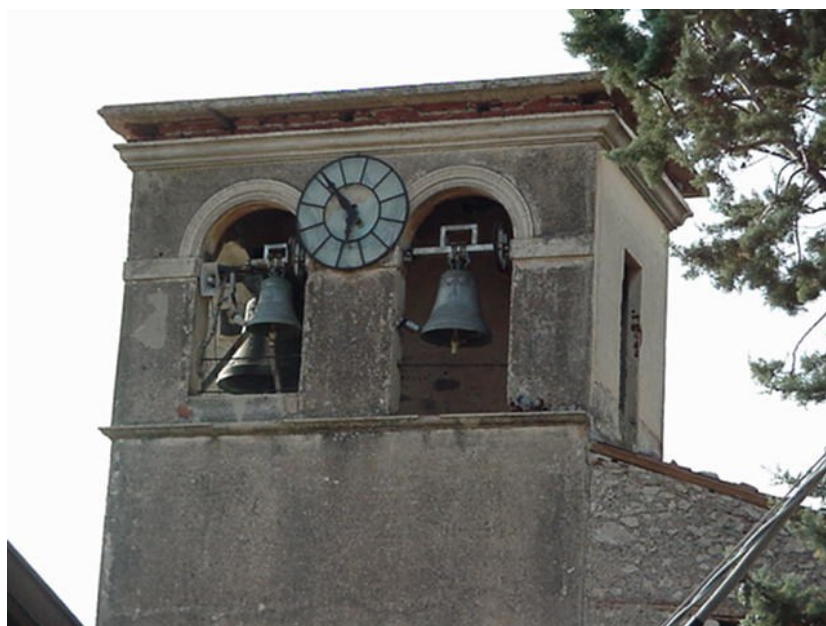
Figura 7 - Quadrante orologio, lato Est; anno 2010
