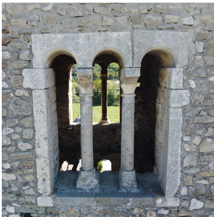
Figura 3 - Carsoli, chiesa del cimitero, anno 2026
